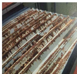
▼正面玄関脇 通路屋根
