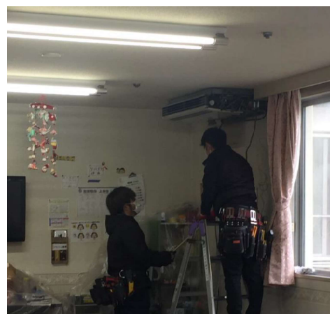
▼事務室（エアコンを取り付けている工事中）
