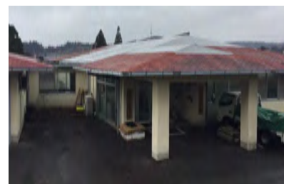
▼防水シートを貼り付けた屋根
