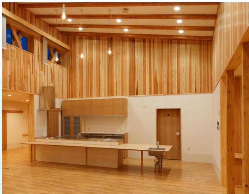
※「現し」とは、「CLTを見せながら、仕上げとして使用することを示す。ただし、建物の規模・用途により、内装制限がかかる場合は、別途せつこうボードを貼るなどの対応が必要」となります。
