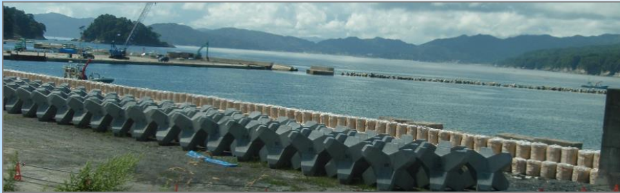
山田町：一時的な簡易防潮堤（2012.9.1撮影）
