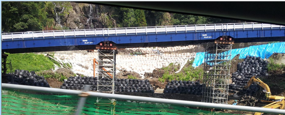
阿蘇市： 橋梁工事現場（2012.9.18撮影）
