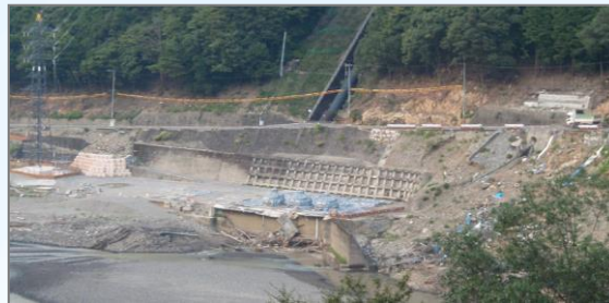
五條市：土砂にのまれた水力発電施跡 （2012.9.21撮影）
