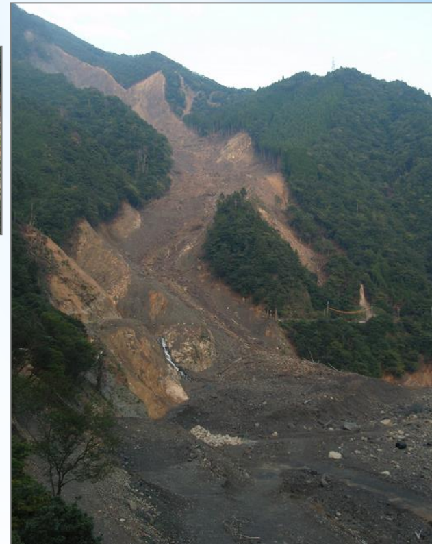
十津川村： 土砂崩れで分断された道路 （2012.9.20撮影）
