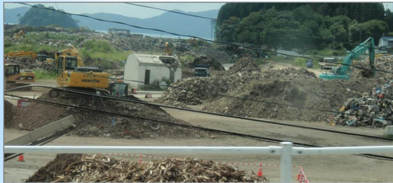
山田町：終わりの見えない撤去作業（2012.9.1撮影）
